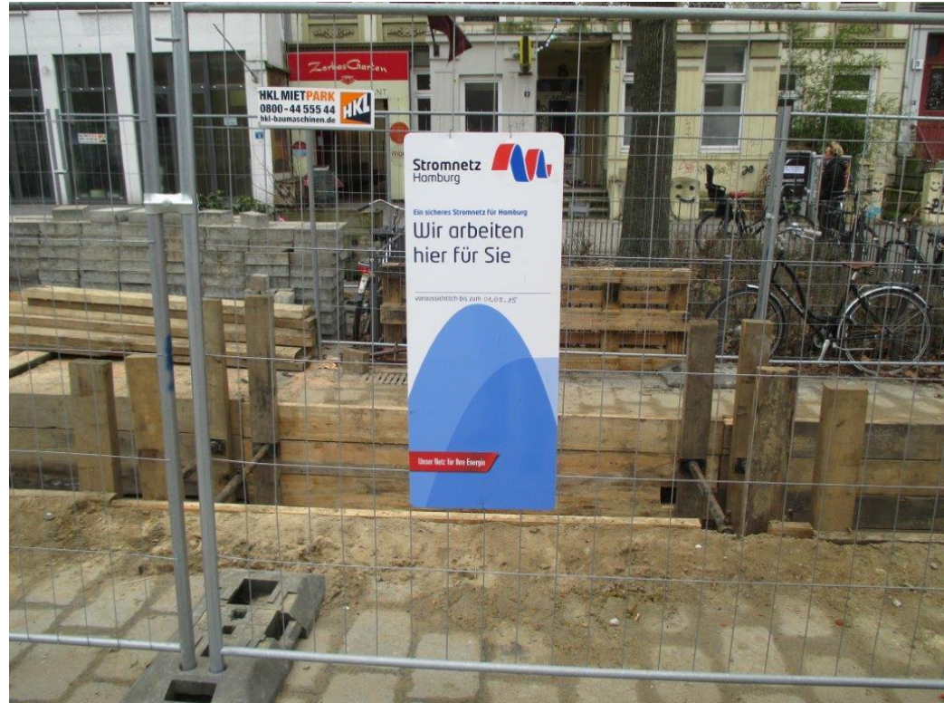
* Baustelle SNH Karoline
