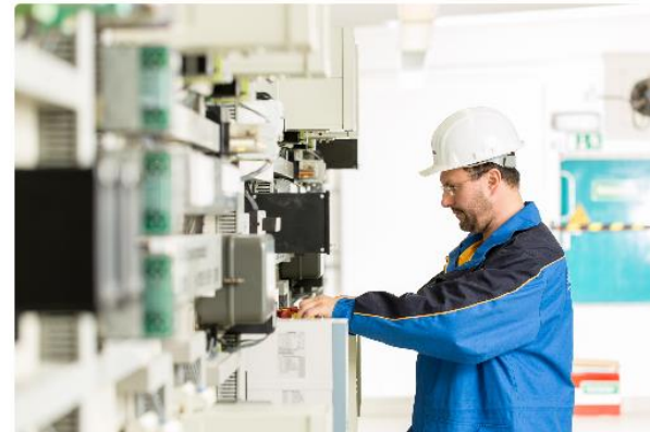
Inbetriebsetzung von Anlagen
